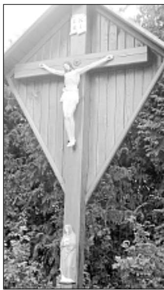
Das 200 Jahre alte Feldkreuz wurde in Zusammenarbeit der Stadt und ihrer Bürger saniert. Foto: iwf
